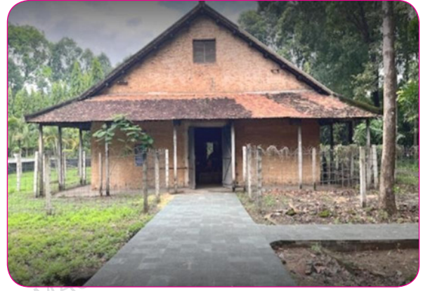
Hình 11. Khu trại giam
